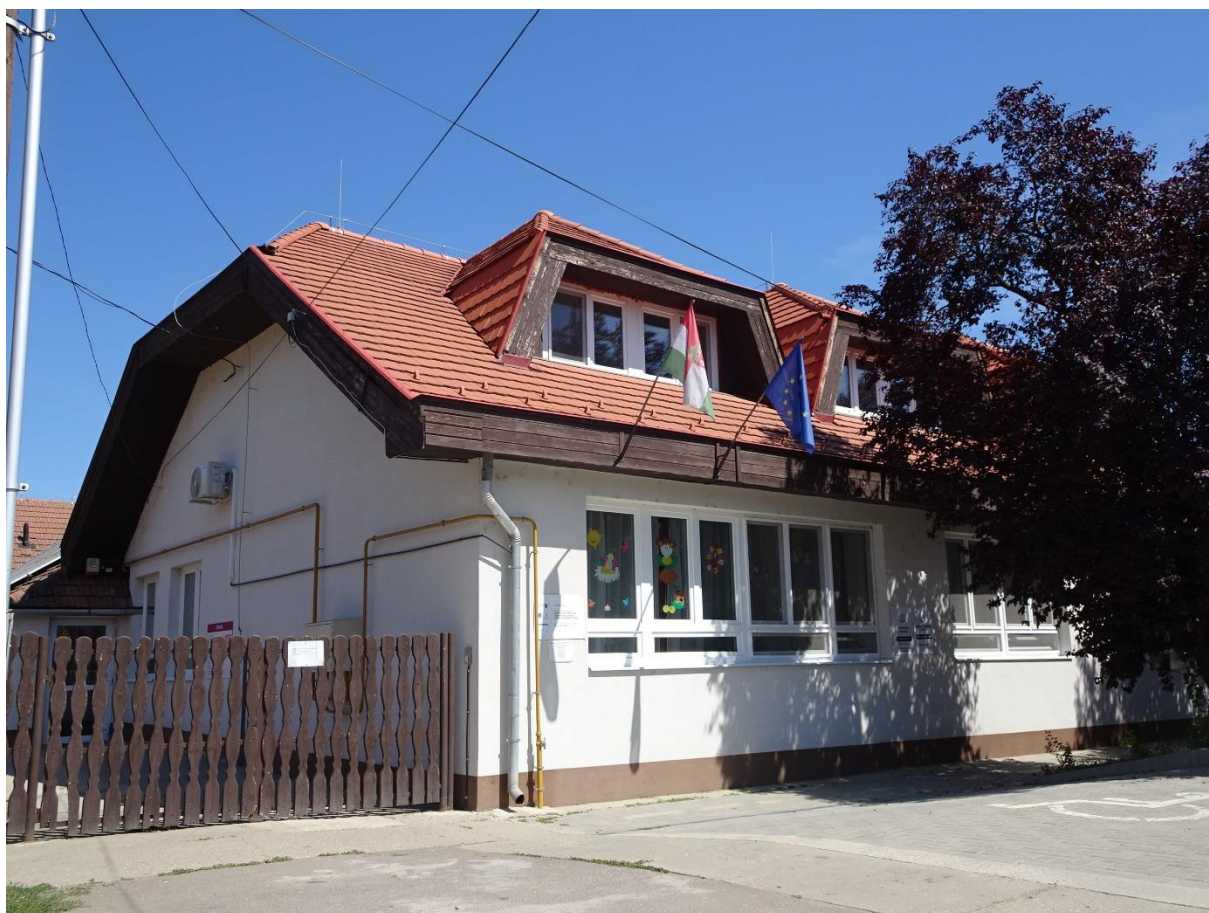
1. kép: Óvoda épülete
